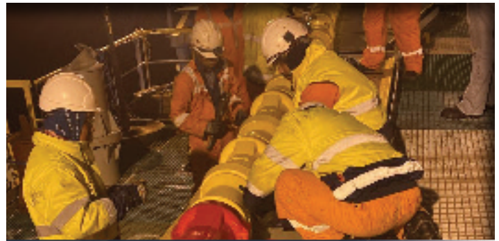
Trabajadores preparándose para conectar un cable entre redes
